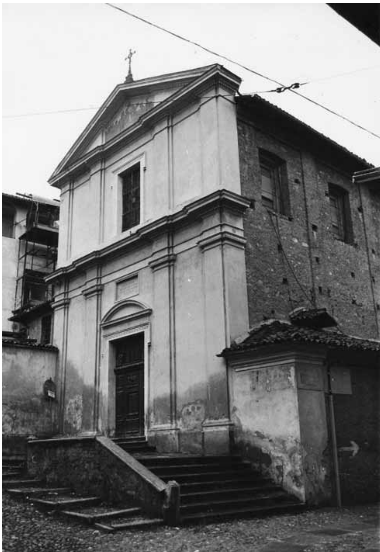
213. Pinerolo, S. Giuseppe, Fassade.
